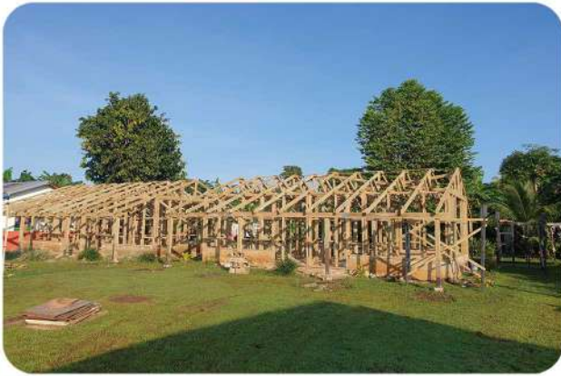
▲ 선교센터 내 스텝 하우스 재건축 중.
